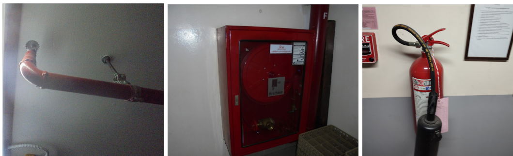
3-15 ระบบดับเพลิงอัตโนมัติชนิดหัวกระจายน้ำดับเพลิง และถังดับเพลิงเคมีแบบมือถือ Dry Chemical CO 2
