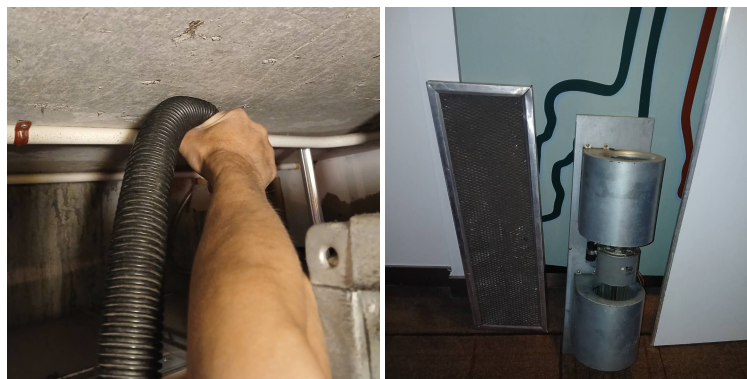
ภาพที่ 3-31 ทำความสะอาดเครื่องปรับอากาศ
